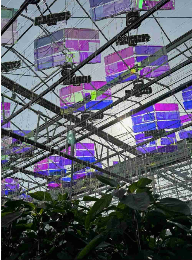
Voltiris (à g.) a développé des modules de panneaux photovoltaïques compatibles avec les serres. Terrabloc (à dr.) fabrique des blocs de terre compressée à partir de déchets d'excavation. Ces derniers sont ensuite utilisés à l'intérieur des habitations. DR/paolacorsini
