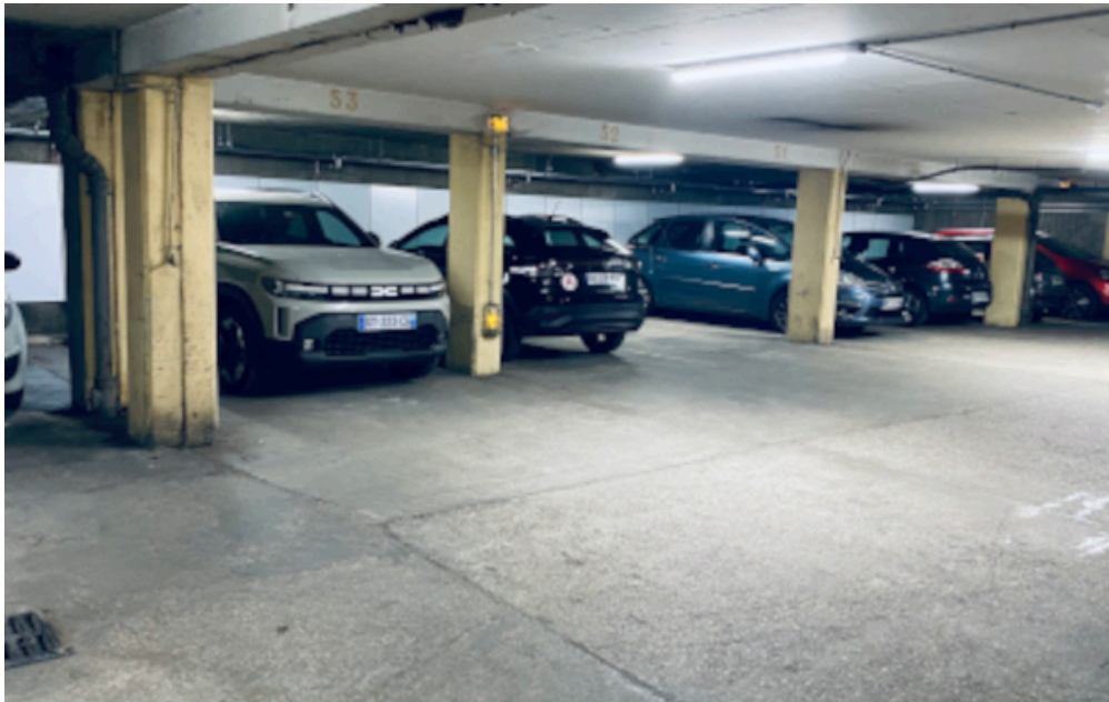
Avec leur épaisseur totale de 2 cm, les panneaux ne gênent pas le stationnement. © Jgp
